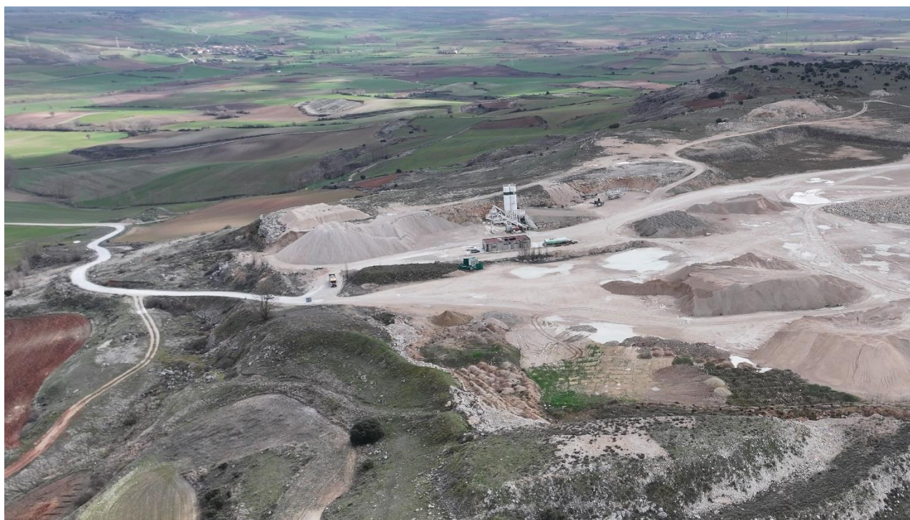
Vista de las instalaciones y edificación al Norte de la parcela 5512 polígono nº 507. Acceso a la cantera.
