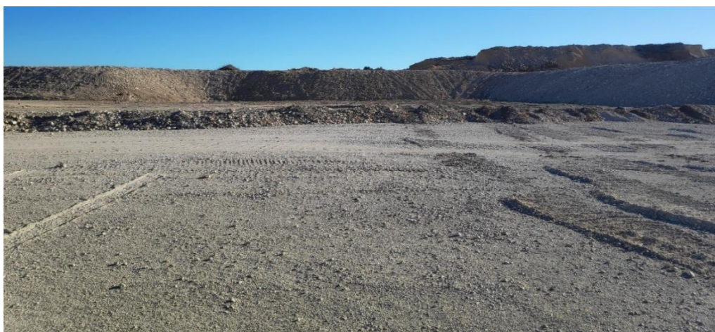
Detalle de la construcción de nuevo suelo fértil en plaza de cantera
