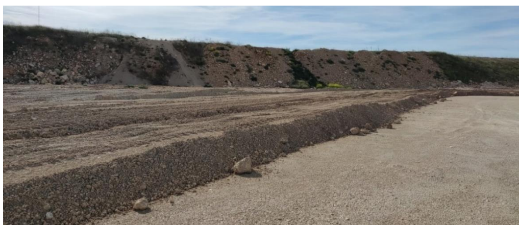
Nivelación del terreno, extendido de esteriles y tierra (construcción de nuevo suelo fértil)
